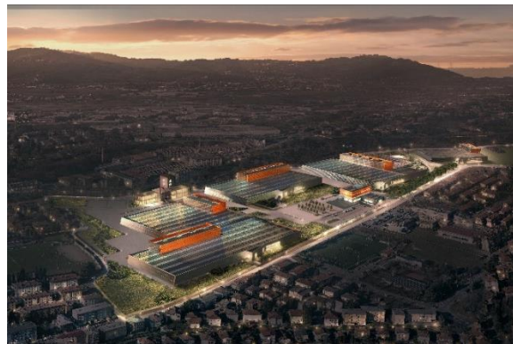
Figura 3 – Data Center IT3
