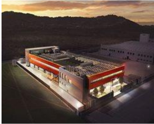
Figura 1 – Data Center IT1
